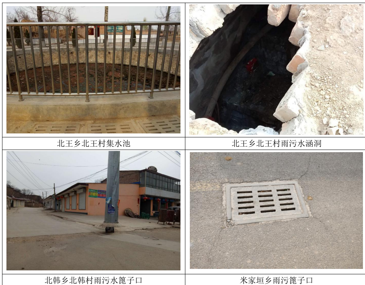
图 3-3 污水管网铺设现状
